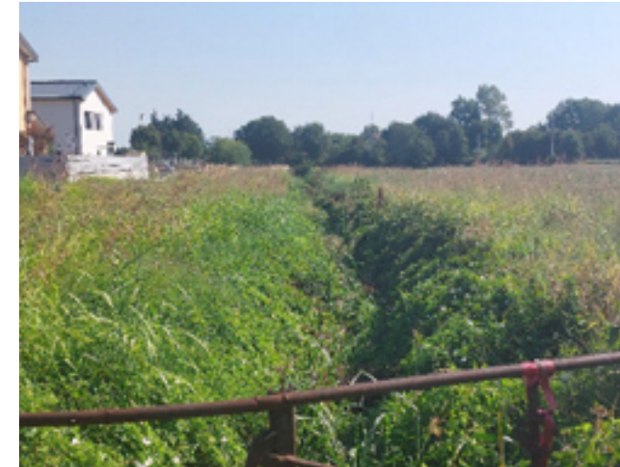
1 - Vista del tratto verso nord da interpodereale a nord della SP 53
