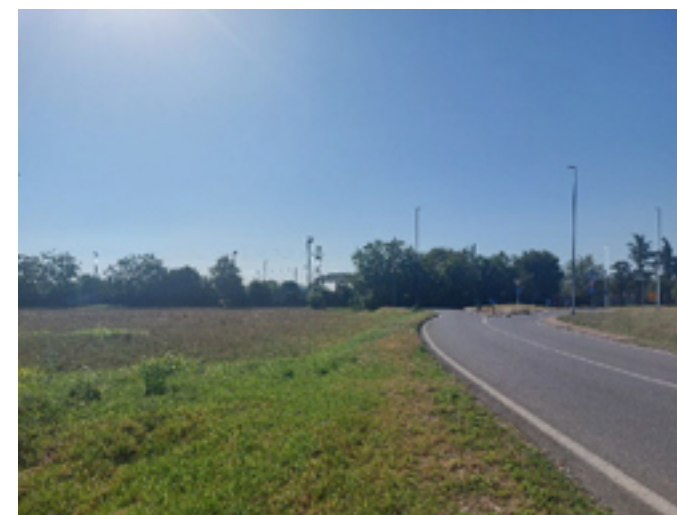
1 - Vista da ovest del terreno a nord della rotonda esistente su SP 53
